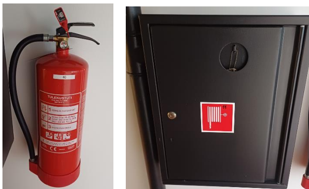
Fotodel – 6kg ABC pulberkustuti ja tuletõrje voolikukapp
