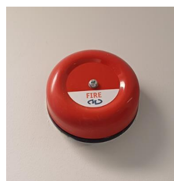
Fotodel – Tulekahju teatenupp mis võimaldab tulekahjuhäire aktiveerida käsitsi, tulekahjuandur, mis jälgib pidevalt ruumi või selle osa tulekahju tekkimisega seotud füüsikalisi ja keemilisi nähtuseid ning alarmeerimiseseade ehk häirekell, mille abil hoones viibivad kuulevad süsteemi häirest.
