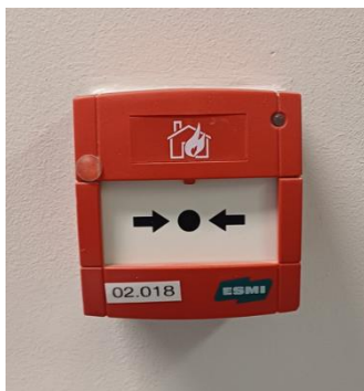
Fotodel – Tulekahju teatenupp mis võimaldab tulekahjuhäire aktiveerida käsitsi, tulekahjuandur, mis jälgib pidevalt ruumi või selle osa tulekahju tekkimisega seotud füüsikalisi ja keemilisi nähtuseid ning alarmeerimiseseade ehk häirekell, mille abil hoones viibivad kuulevad süsteemi häirest.
