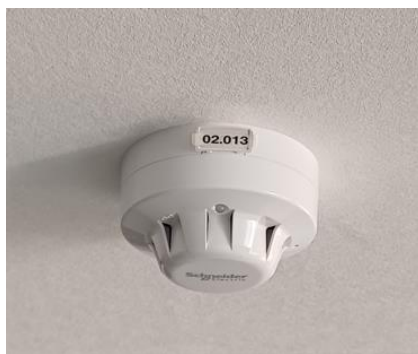
Fotodel – Tulekahju teatenupp mis võimaldab tulekahjuhäire aktiveerida käsitsi, tulekahjuandur, mis jälgib pidevalt ruumi või selle osa tulekahju tekkimisega seotud füüsikalisi ja keemilisi nähtuseid ning alarmeerimiseseade ehk häirekell, mille abil hoones viibivad kuulevad süsteemi häirest.
