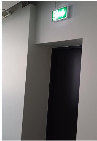
Fotodel – evakuatsiooniteele ja evakuatsiooniteel asuvatele ustele viitavad evakuatsioonivalgustid
