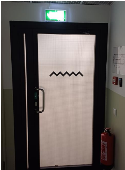
Fotodel – evakuatsiooniteele ja evakuatsiooniteel asuvatele ustele viitavad evakuatsioonivalgustid
