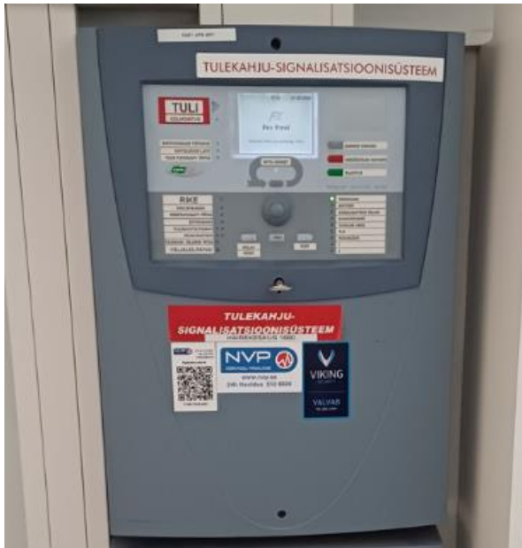
Fotol – ATSi keskseade, mis asub 1.korrusel peaukse juures, fuajees (ühtlasi ka päästemeeskonna sisenemistee)
