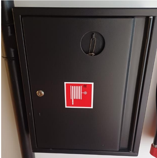
Fotodel – voolikukapp (suletud ja avatud asendis)
